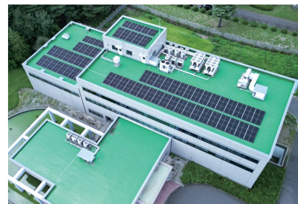
ローツェライフサイエンス株式会社では、自社の施設に太陽光発電システムを導入し、年間で約66万5千kWhの電力を発電、自家消費しています。
