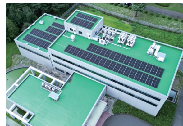
ローツェライフサイエンス株式会社では、自社の施設に太陽光発電システムを導入し、年間で約66万5千kWhの電力を発電、自家消費しています。
