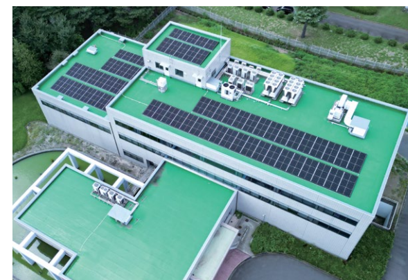
ローツェライフサイエンス株式会社では、自社の施設には太陽光発電システムを導入し、年間で約66万5千kWhの電力を発電、自家消費しています。
