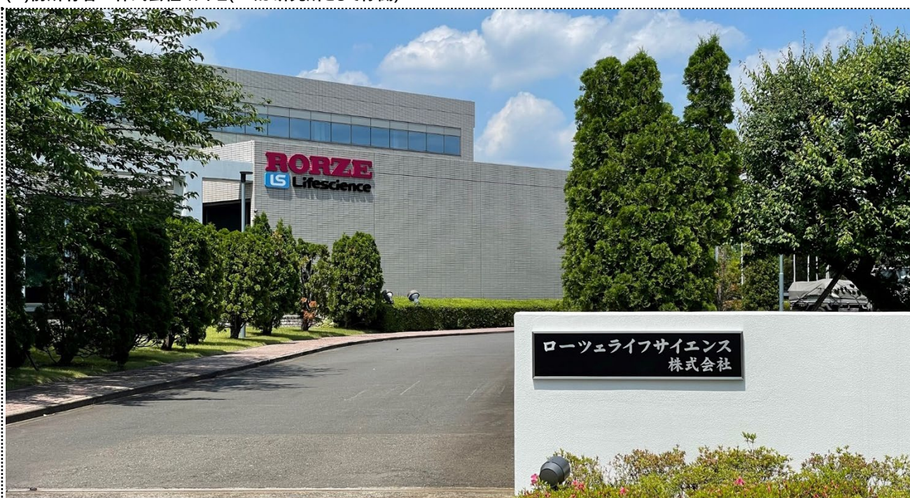
画像④新研究施設の外観
