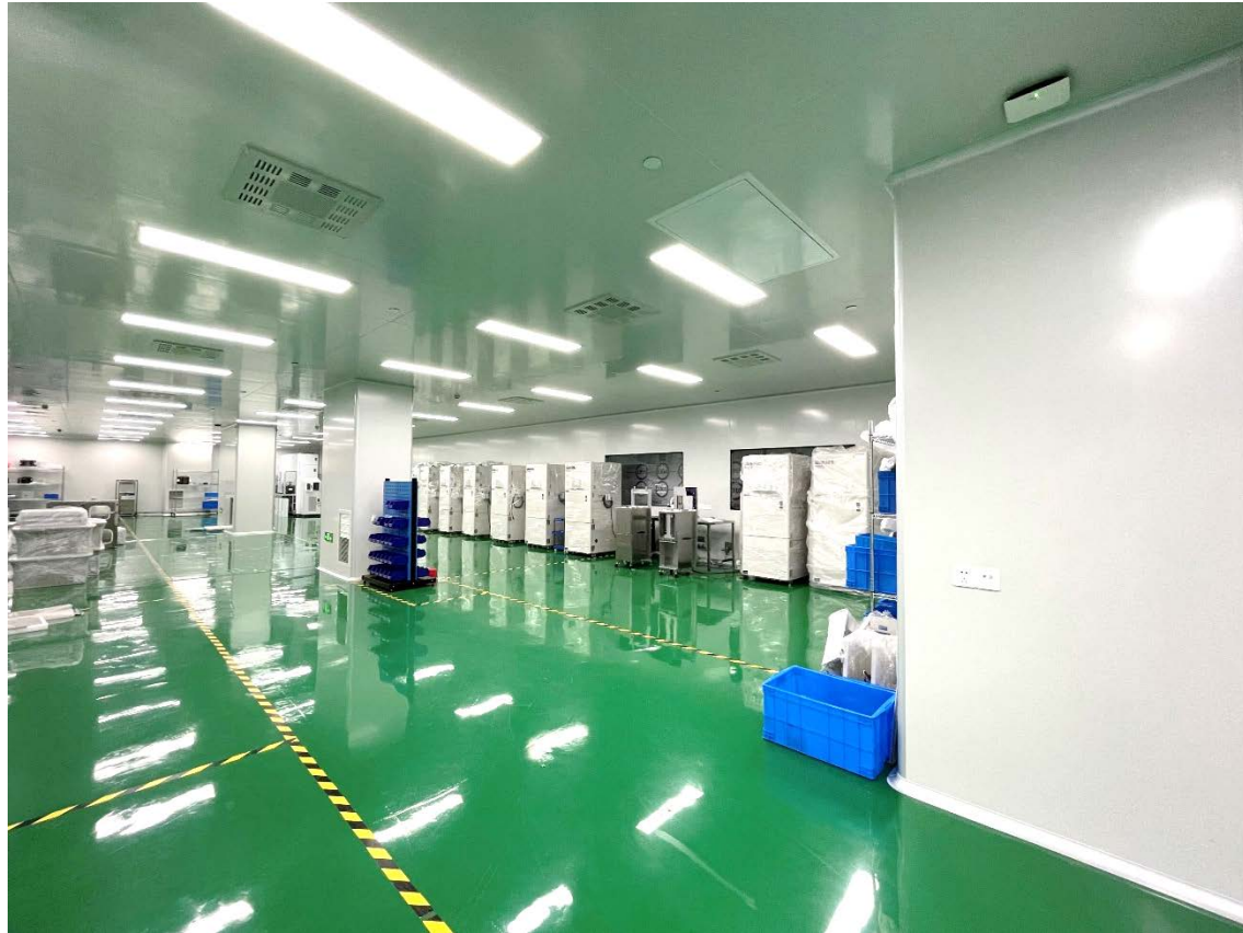
中国子会社のクリーンルーム
