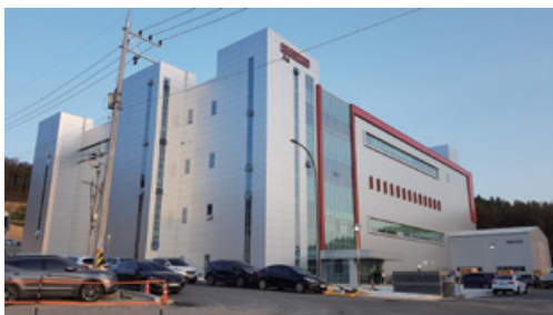
完成した第1棟外観
