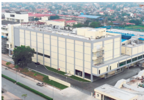
第5、第7工場外観
