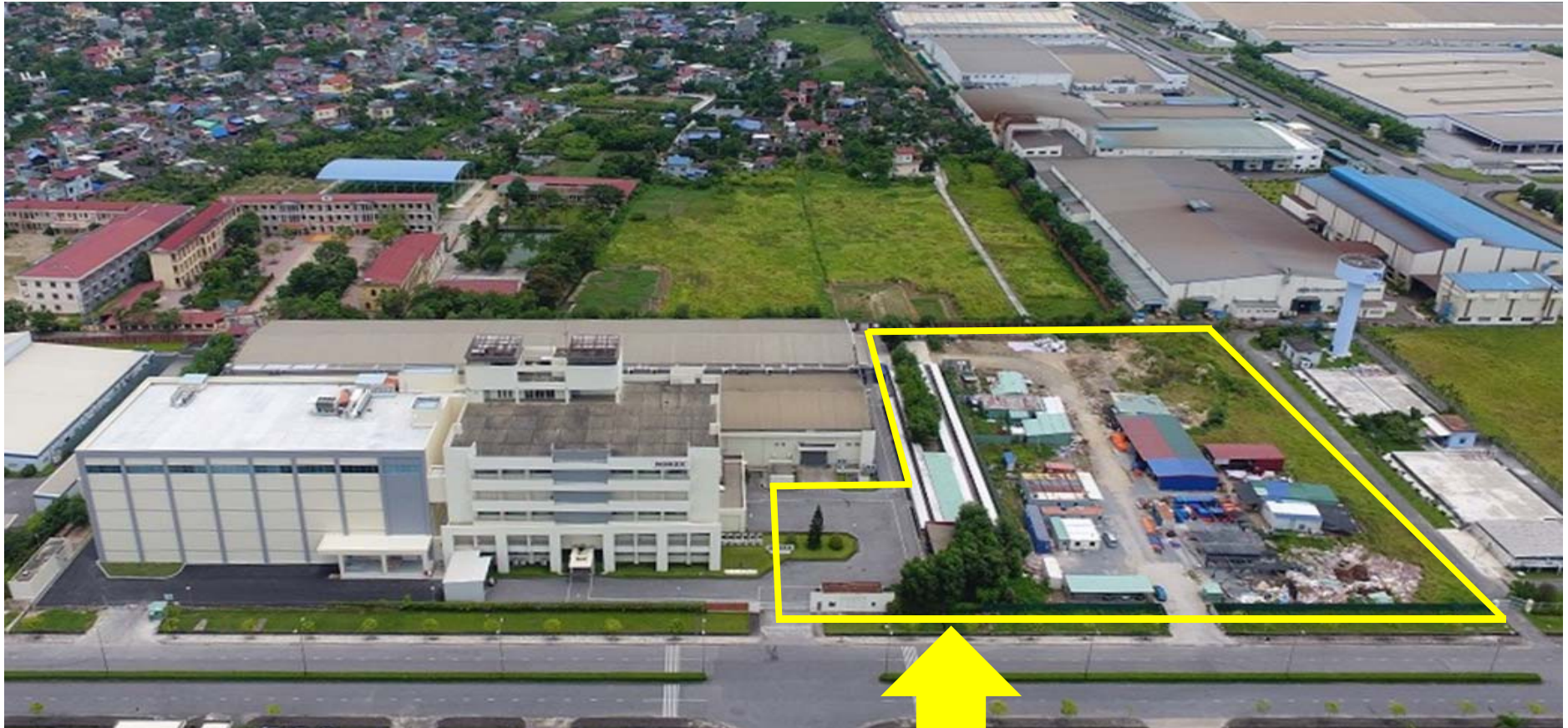
第5、第6工場 建設予定地
