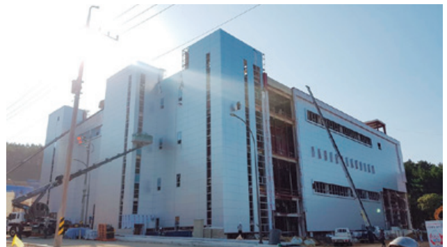
新社屋・工場を新築中のRORZE SYSTEMS (韓国)
